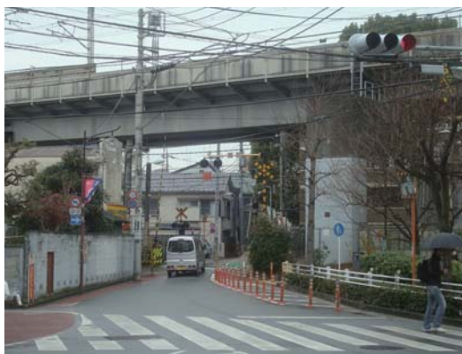
追加の205号線新区間となる原踏み切り
