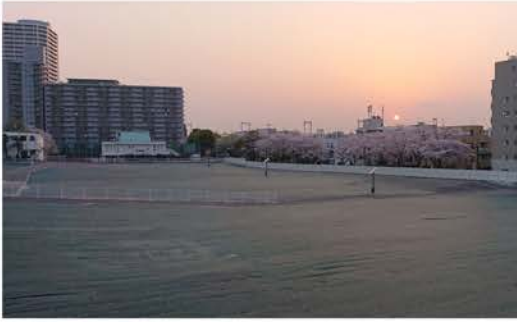
解体工事が終わり、更地となったニコン跡
