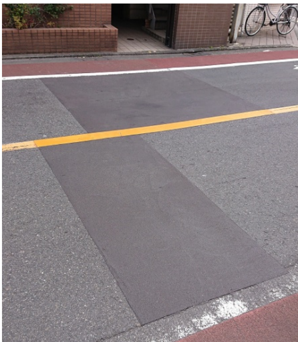
大井5丁目の補修工事が終了した滝王子通り
