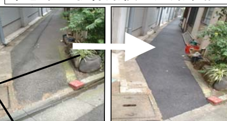
東急中延駅線路横の道路改修
