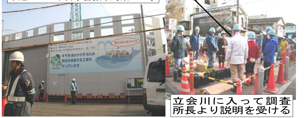
中延2～6丁目水害抜本対策の工事
