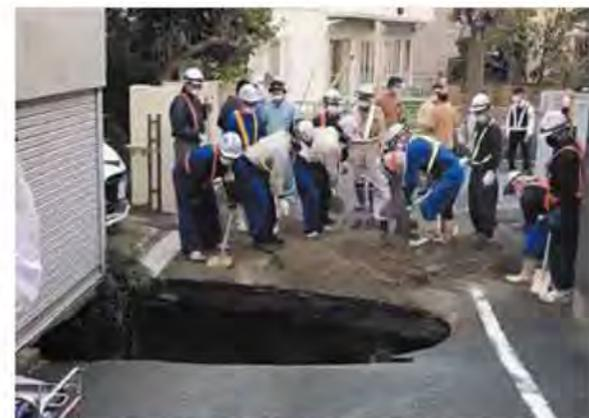
5m×3m、深さ5mの調布市の陥没
