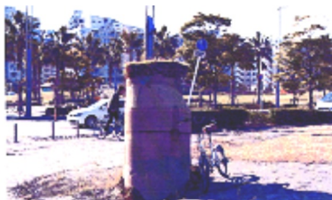
せり上がったマンホール
