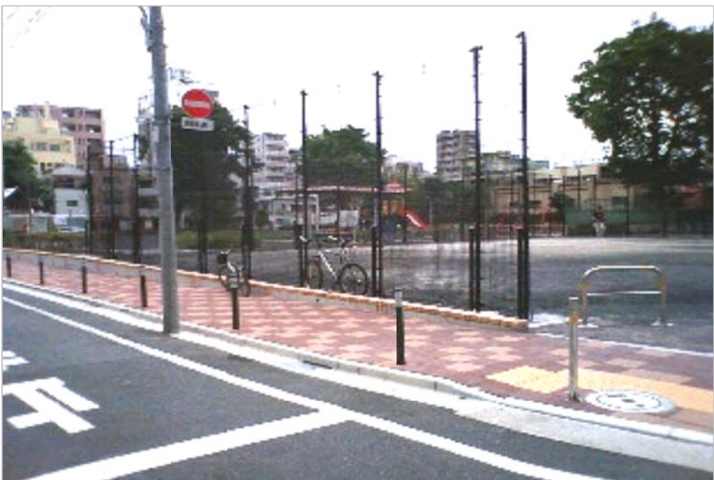
改修工事が終わった鈴が森公園。フェンス内の地下に貯留施設があります。
