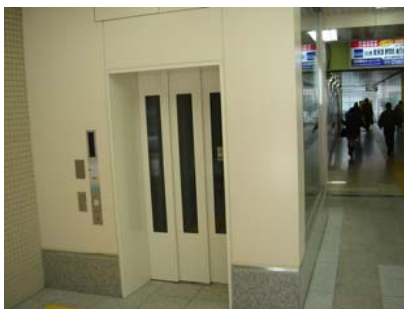
4月に設置されたエレベーター
