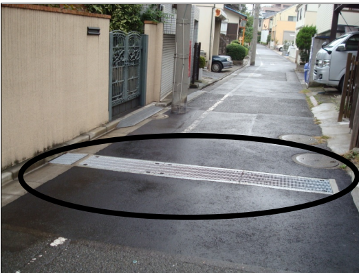
大井6丁目に完成した横断グレイチング（マル印）。設置により、道路が雨水で川のように流れることを防ぎます。
