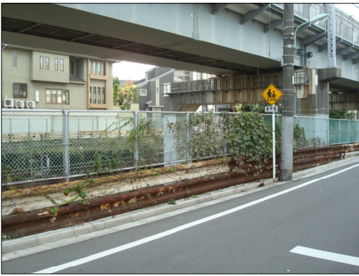
サビたガードレール。年度内に改修工事が行われます。西大井5丁目
