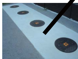
西大井六丁目ふれあい広場の「防災トイレ4基」は、この辺りです。
