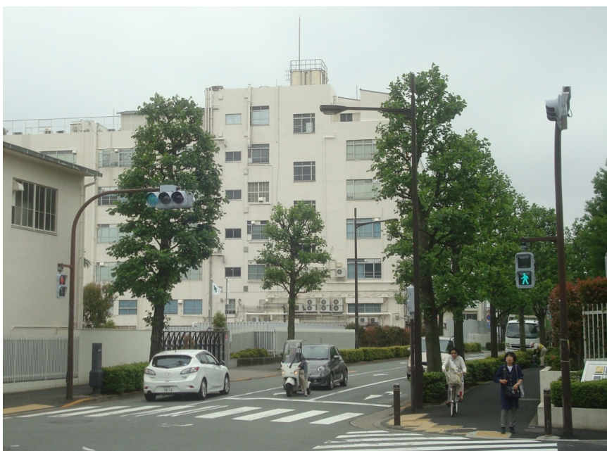
写真は、解体工事前の「懐かし」ニコン101号館の姿。現在は解体工事がほぼ終了し、今年9月末にも更地になる予定です。
