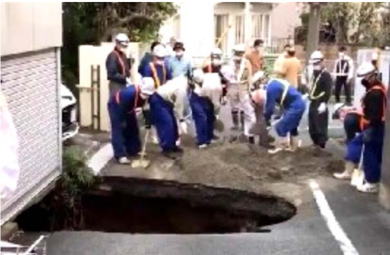
調布市の陥没事故現場 (2020, 10)
